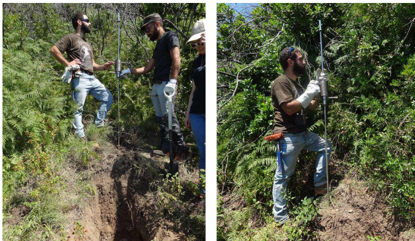
Figura 41 - Esecuzione di prove penetrometriche dinamiche leggere.
