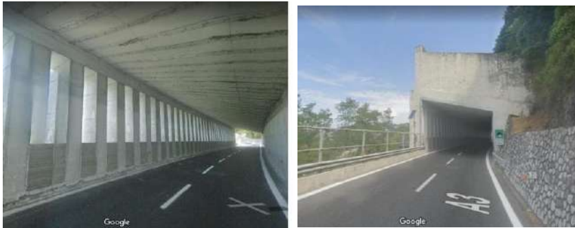
Figura 75 – A sinistra, vista interna della galleria paramassi; a destra, imbocco della galleria paramassi
